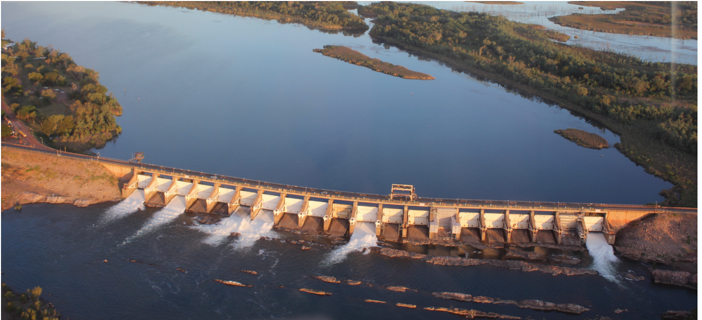
Kununurra Diversion Dam
