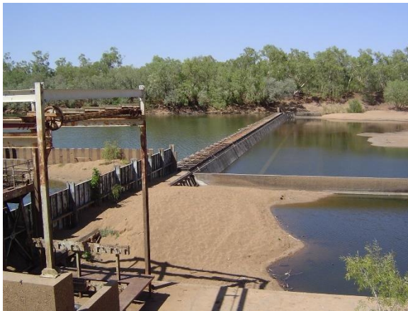
c) Fitzroy Barrage
