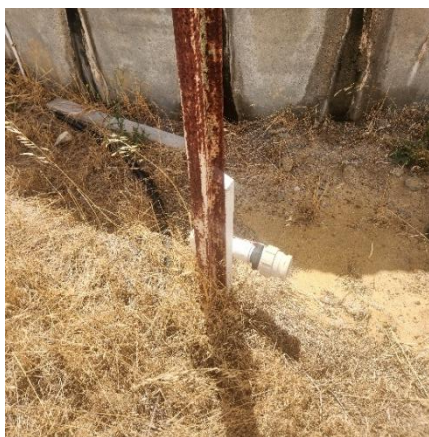
Fill point coupling
